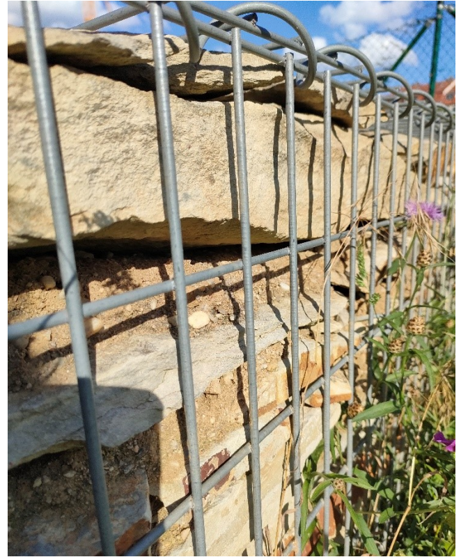
Abbildung 12: Gabionen gefüllt mit Bruchsteinen und Lehm
