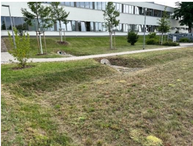
Abbildung 35: Sickerbecken mit teilweise offenem Zulauf aus Dachentwässerung
