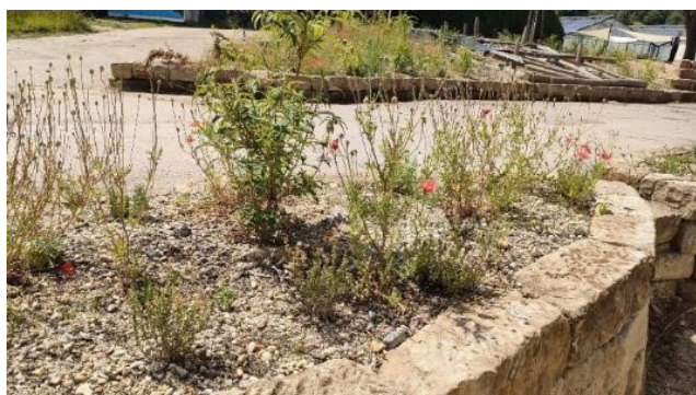
Abbildung 25: Trockenmauer mit Kiessandhinterfüllung
