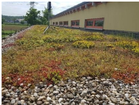
Abbildung 29: Extensiv begrünte Dachfläche
