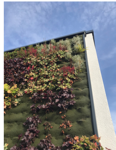
Fassadengebundene Begrünung in Koblenz (D. Spurzem, 2024)
