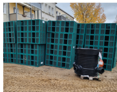
Rigolen vor Einbau in Berlin Biesdorf (BGS 2023)
