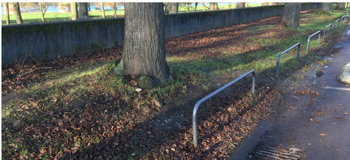
Abbildung 23: Niedrige Rundrohrbügel halten in Köln Parkplatzsuchende von Grünanlagen ab. Foto: Daniel Gerhardt 2025
