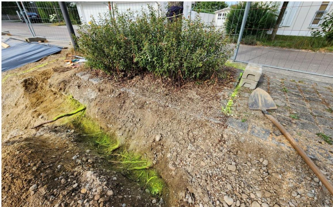
Abbildung 37 Wurzelsondierung per Handsichtung: Schaufeleinsatz. Foto: Annette Hartmann, 2025.
