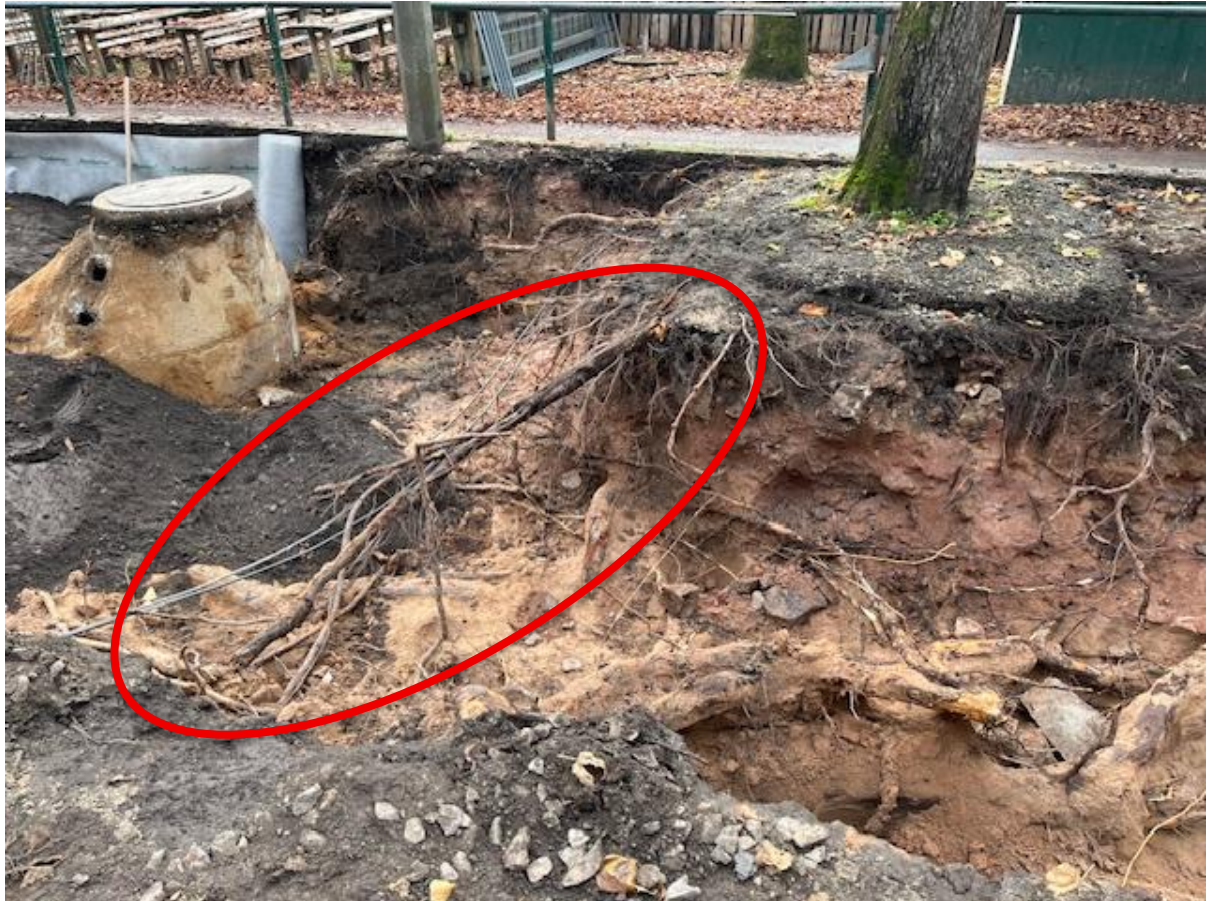
Abbildung 39: Erlangen: Dank Saugbagger blieben solche Starkwurzeln erhalten. Foto: Marco Müller 2018
