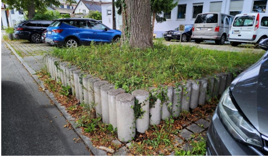
Abbildung 25 Germering: Als die Straße "tiefergelegt" wurde, bekam dieser Baum sein Hochbord. Foto: Annette Hartmann 2025
