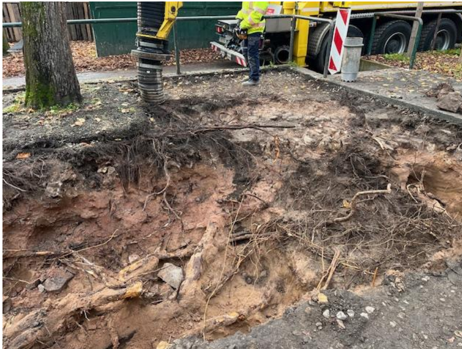
Abbildung 38: Großer Saugbagger im Einsatz auf Biergartengelände in Erlangen. Foto: Marco Müller 2018
