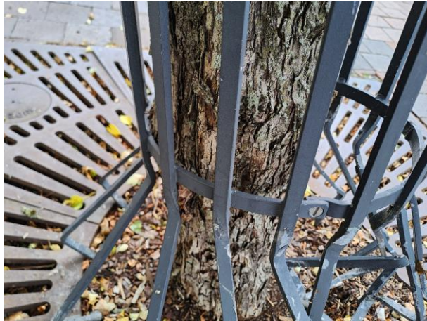
Abbildung 32: Handelsübliches Baumschutzgitter in Rosettenform. Foto: Annette Hartmann 2025
