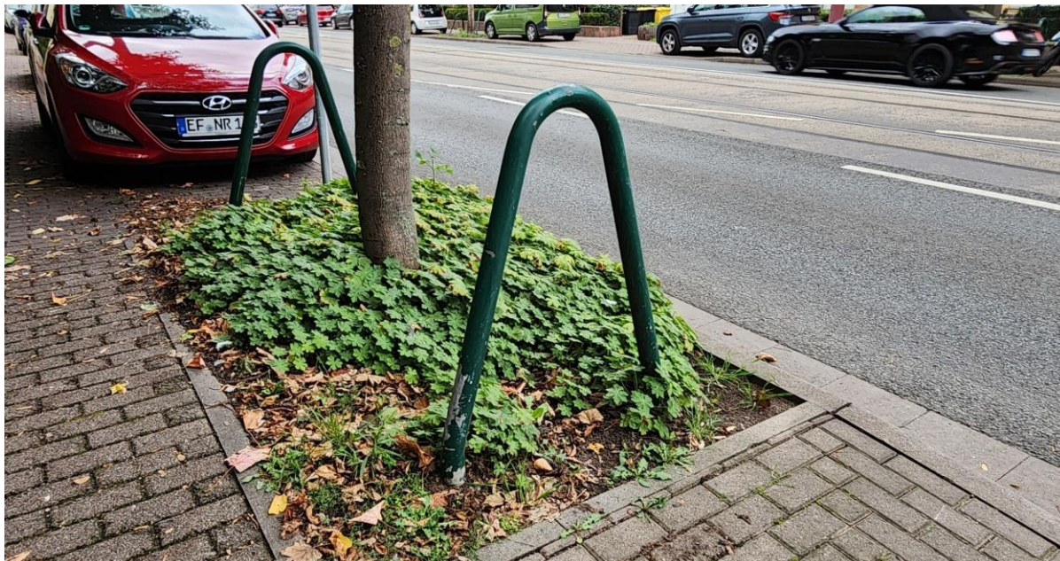
Abbildung 22: Hohe Rundrohrbügel aus Metall schützen die Baumscheibe vor rangierenden Autos in Erfurt. Foto: Annette Hartmann 2025
