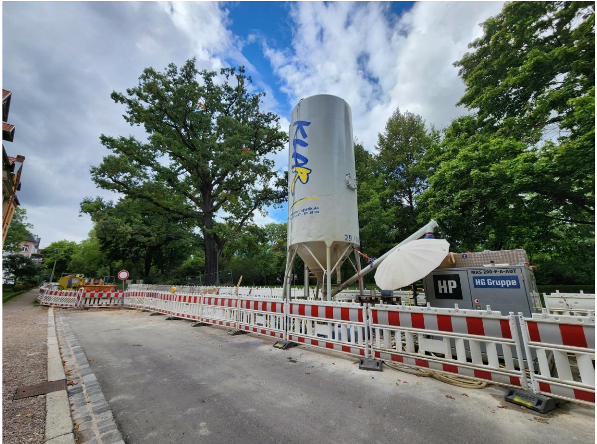
Abbildung 41 Erfurt: Hier werden sogar Wasserrohre unter Wurzeln "durchgeschossen". Foto: Annette Hartmann, 2025
