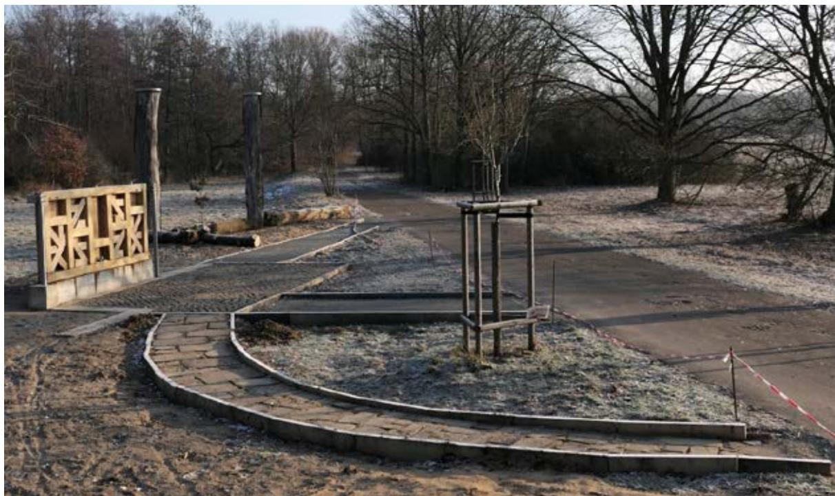
Die Wildbienenstation ist Bestandteil eines Natur-Erleben-Pfades mit insgesamt zehn Stationen. Hauptbestandteile der noch im Bau befindlichen Station sind eine große Fachwerkwand mit Materialien für röhrennistende Wildbienenarten, eine Fläche mit lehmigem Sand für Erdnister, zwei Flächen für Pflanzungen heimischer Stauden, verschiedene Wegebeläge, teilweise in Sand gesetzt sowie in den Randbereichen Wildblumenansaat und blütenreiche Sträucher.
