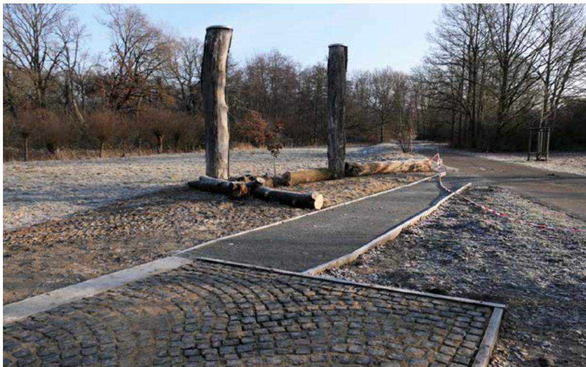
Die oben hohlen Eichenstämme der ursprünglichen Bienenstation dienen Hornissen als Nistplätze, die 60 cm tief ausgekofferte Fläche davor wurde mit lehmigem Sand verfüllt und leicht verdichtet. Die Wegebeläge aus Polygonplatten und Kleinpflaster wurden in lehmigen Sand gesetzt, um auch hier Nistmöglichkeiten für Bodennester zu schaffen.
