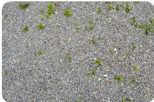
Chaussierungen sind Wegbauweisen mit einem wassergebundenen Deckbelag aus bindigem Kiesmaterial, welcher mit Sand, Splitt oder Gartenkies abgestreut werden kann. Chaussierungen werden ohne Zusatz von Bindemitteln wie Bitumen oder Teer eingebaut, und nur vom enthaltenen Kalk zusammengehalten. Die Tragfähigkeit und Befahrbarkeit hängt von der gewählten Kofferung ab; entsprechend eignen sie sich als Fuss- oder Velowege und Parkplätze.
