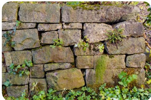
Trockenmauern bestehen aus leicht nach hinten aufeinandergeschichteten Natursteinen. Zwischen den Natursteinen befinden sich grössere und kleinere Fugen, Spalten und Ritzen. Sie enthalten keinen Mörtel oder andere Bindematerialien.
