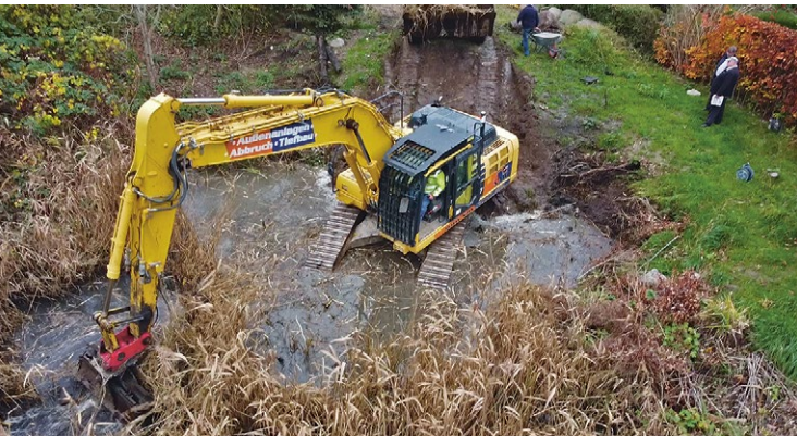
Baggerarbeiten zur Entschlammung eines verlandeten Dorfteiches auf der Insel Rügen.
