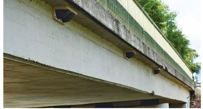
Mehlschwalben-Nisthilfen an einer Brücke.
