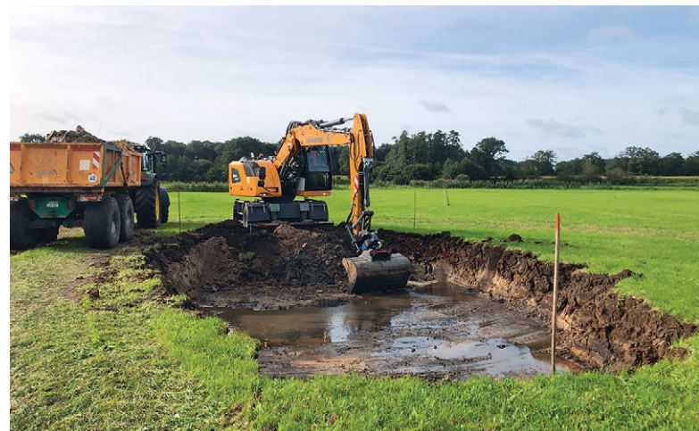
Baggerarbeiten zur Neuanlage einer Senke.
