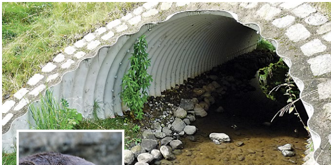
Künstliche Uferstreifen (sogenannte Bermen), Steinschüttungen oder Laufstege helfen dem Fischotter ( Lutra lutra ) beim Unterqueren von Brücken.
