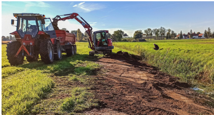
Maßnahmen, wie z. B. das Abflachen von Gräben, können auch durch Landwirt:innen umgesetzt werden.
