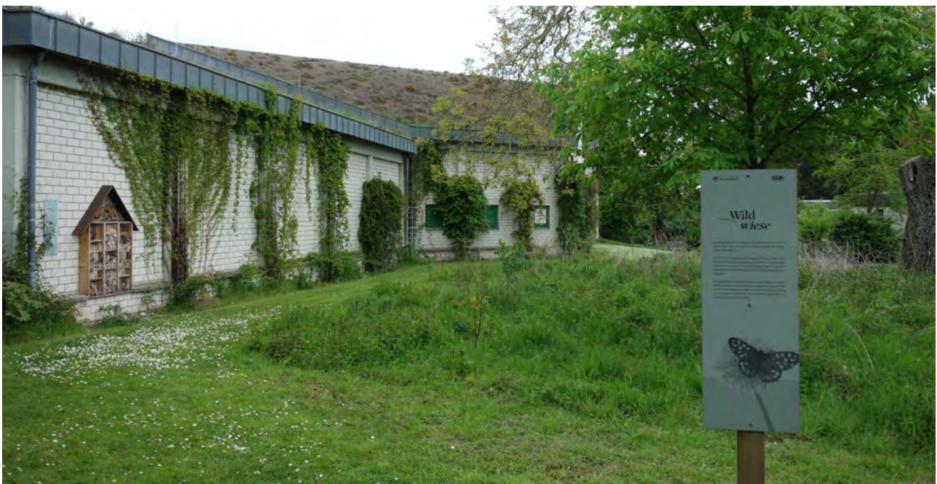
Biodiversitätsfördernde Maßnahmen an Gebäuden umsetzen: extensive Gründächer, Fassadenbegrünung, Nisthilfen für Insekten und eine Wildblumenwiese auf dem Abstandsgrün. Das Gebäude des Landschaftsverbands Rheinland in Brauweiler zeigt auf, was möglich ist. (R. Hansen)
