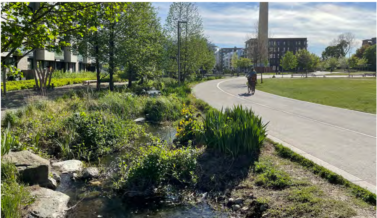
Gewässer renaturieren: Der zuvor kanalisierte Abschnitt des „Hovinbakkens“ in Norwegens Hauptstadt Oslo wurde wieder offen gelegt. Der Schutz vor Überschwemmung in Folge zunehmender Starkregenereignisse und Überlastung der verrohrten Wasserläufe bei gleichzeitiger Schaffung von Habitaten und der Aufwertung des Wohnumfeldes waren die Anlässe der Renaturierung. Dies begünstigt zudem Erholung und Mobilität zu Fuß und Rad. (B. Kupilas)
