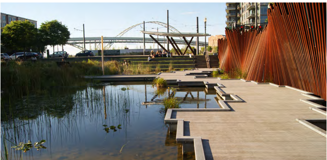
Naturnahe Schwammparks anlegen: Im Tanner-Springs-Park in Portland wird Regenwasser gereinigt und zurückgehalten. Die Pflanzung orientiert sich an Feuchtgebieten der Region und durch ein Zonierungskonzept mit unzugänglichen Bereichen entstehen auf kleiner Fläche Rückzugsräume für Tiere. (R. Hansen)
