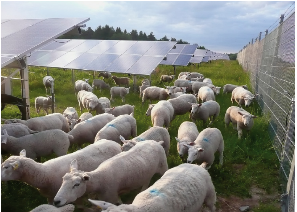
Abb. 6.2: PV-Freiflächenanlage mit Beweidung zur Offenhaltung der Fläche (Foto: Energiegenossenschaft Odenwald e. G.)
