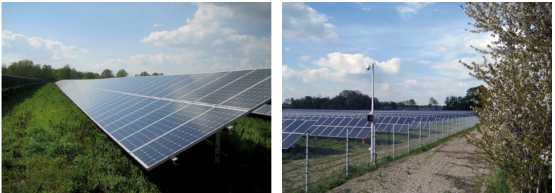
Abb.6.5: Ansicht einer PV-Freiflächenanlage mit Einzäunung (Fotos: Bernd Demuth)
