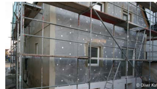
Energetische Sanierung der Fassade mit einem Wärmedämmverbundsystem
