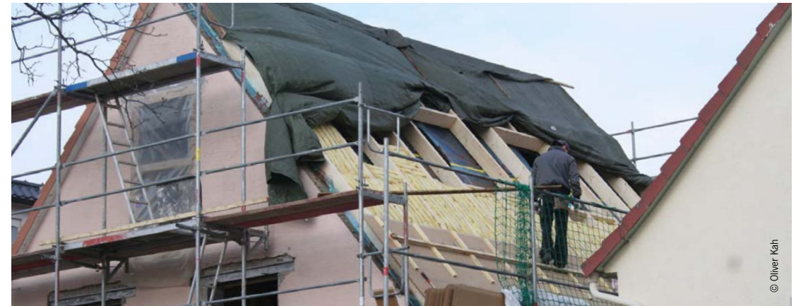
Wärmedämmung des Daches durch eine „Aufdopplung“ der alten Sparren
