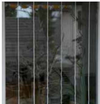
Bei Holzfenstern praktisch und günstig: Beidseitig an Rahmen je 1 Nagel einschlagen, Gummiband spannen und alle 10cm eine dicke weisse Nylonschnur anknüpfen.
