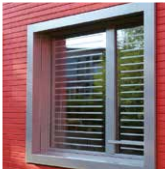
Für langlebige, dezente Aussenanwendungen: Oracal Kristallfolie ab Band. Bei horizontaler Montage beträgt der Abstand idealerweise 8cm.
