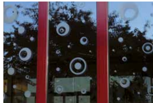
Motive aus Kristallfolie bieten – wenn relativ dicht aufgebracht – recht guten Schutz. Sie sind an sich in beliebigen Formen produzierbar.
