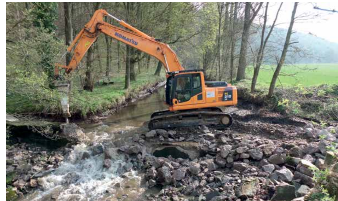
Wiederherstellung der Durchgängigkeit eines Gewässers (Foto: Joachim Wöhler)
