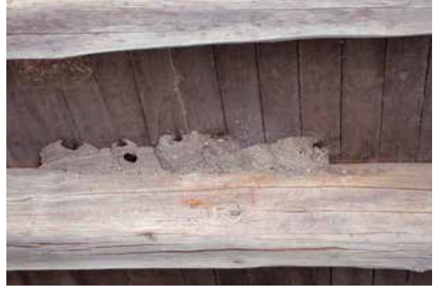
Mehlschwalben, die ins Innere des Gebäudes einziehen (Foto: Hof Schünemann, Kreis Verden)
