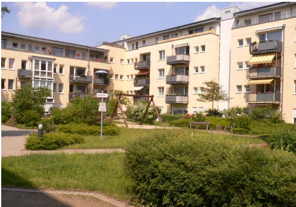
Abbildung 7: Auch kleine Grünflächen zwischen Wohnhäusern können zur Vernetzung der Grünräume beitragen. Foto: B. Kochan/IÖR-Media, Dresden
