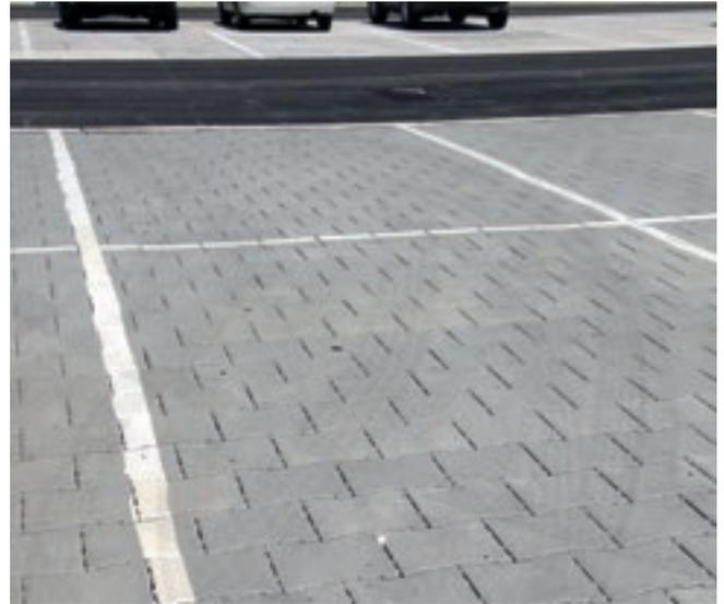
26 Versickerungsfähiges Pflaster
