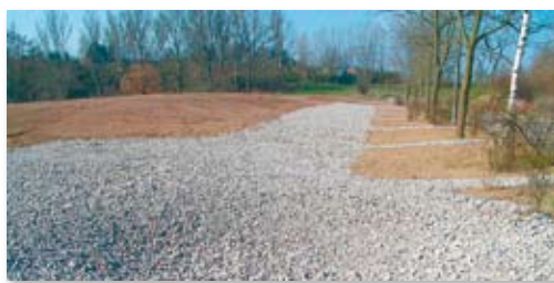
Die Fläche unmittelbar nach Aufbringen des Recyclingmaterials
