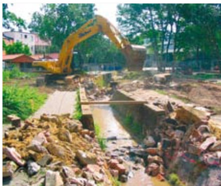
Abriss der Sohl- und Uferverbauung
