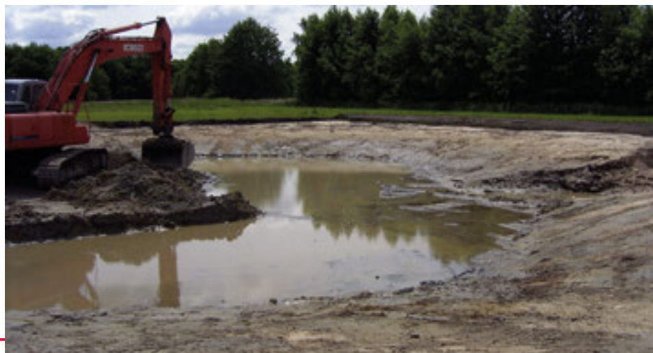
Anlage eines neuen Kleingewässers | © LHH
