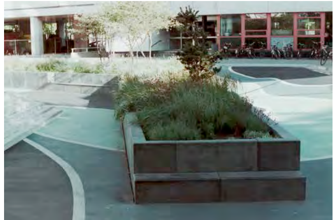
Der Wasserplatz Bentheplein in Rotterdam wirkt wie ein konventioneller Stadtplatz. Sobald es heftig regnet, entfaltet er jedoch seine volle Leistung als Kombination aus grüner und grauer Infrastruktur durch Rückhaltung und langsame Versickerung von Regenwasser (K. Lindschulte)
