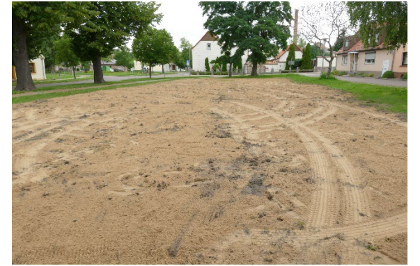
22.07.2021 – Sand aufbringen + einfräsen
