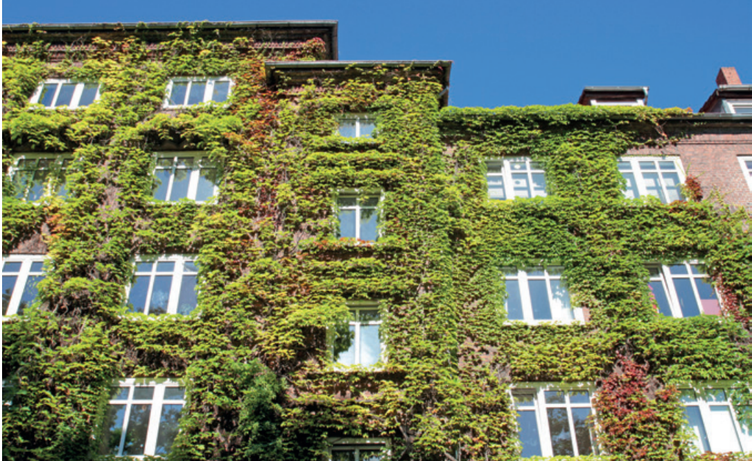
Bodengebundene Begrünung von Fassaden, hier mit Wildem Wein, ist die günstigste Variante bei bestehenden Gebäuden.
