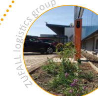
Grüne und moderne Parkraumgestaltung mit versickerungs- und vegetationsfähigen Belägen, heimischen Gehölzen, Wildblumeneinsaat und E-Ladesäulen.
