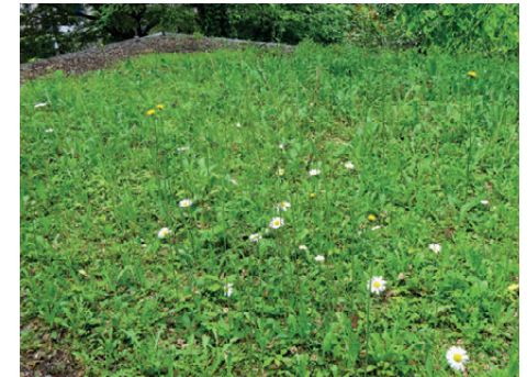
An schattigen Stellen wächst auch auf einem extensiv begrünten Dach eine lockere Wiese.
