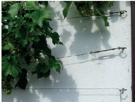
Spanner ermöglichen, dass Drähte nachgespannt werden können.
