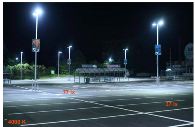
Abb. 3.3: Links ein Parkplatz mit 7 - 16 lx Beleuchtungsstärke und warmweißer (3.000K) LED-Beleuchtung, rechts einer mit 35 - 75 lx Beleuchtungsstärke und neutralweißer (4.000K) LED-Beleuchtung. In beiden Fällen wurde eine voll abgeschirmte Beleuchtung installiert. Links ist die Beleuchtung an die Norm angelehnt, rechts sind wesentlich höhere Lichtmengen eingesetzt. Da der rechte Parkplatz nach Geschäftsschluss kaum genutzt wird, ist ohnehin fraglich, ob er dann noch so hell beleuchtet sein muss.
