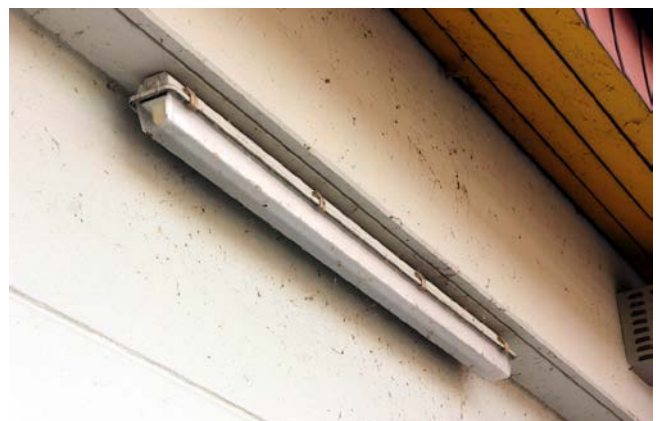
Abb. 3.18: Mit einfachen Mitteln umgebautes Gehäuse für LED-Röhren, das eine blendende Abstrahlung nach vorne vermeidet.
