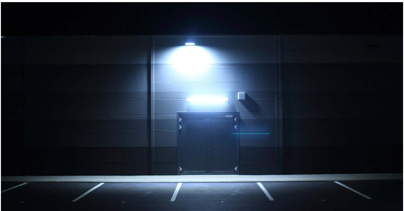
Abb. 3.17: Unnötige Doppelbeleuchtung mit neutralweißen LED: Oben ein Planflächenstrahler, der nur nach unten strahlt, während darunter zusätzlich eine LED-Röhre installiert ist, die ihr Licht in alle Richtungen abstrahlt und blendend wirkt.
