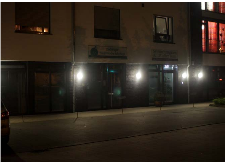
Abb. 3.20: Freistrahkende Wandleuchten blenden und erhellen kaum die Verkehrsfläche.
